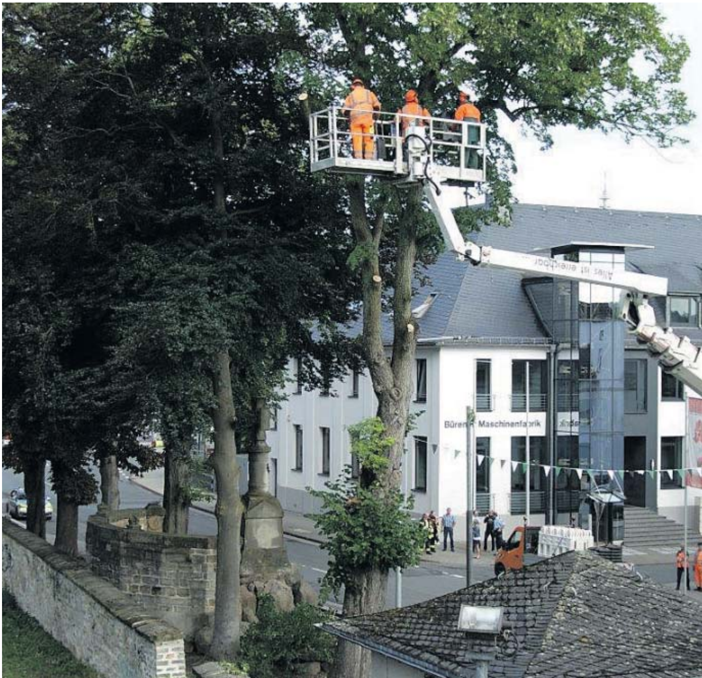
Gefährdete den Straßen- und Fußgängerverkehr: Die alte Linde am Kreiskriegerdenkmal zwischen Bahnhofstraße und Teichgarten wurde gefällt, nachdem ein Seitenstamm in den neuen Durchgang der Mauer gestürzt war.
